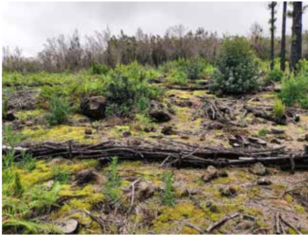
Disposées dans les pentes, les « fajinas », fagots de branches brûlées, empêchent l'érosion du sol. © Loéva Claverie
