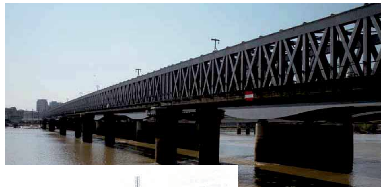
La passerelle Eiffel mesurait 500 mètres avant d'être sectionnée en 2008.
